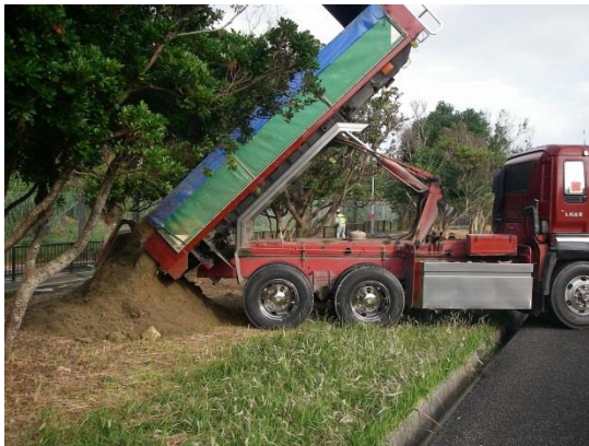
沖縄自動車道での浚渫土搬入
